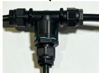
メインケーブル分岐部
